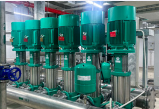
Cụm bơm tăng áp trực đứng biến tần Vertical multistage inverter booster pump set
