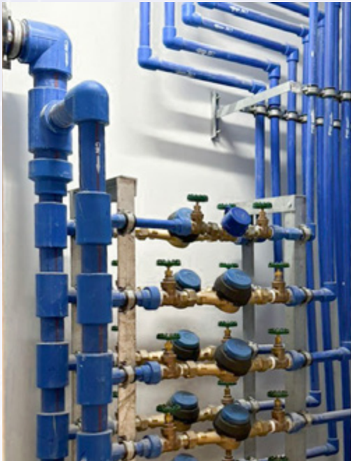
Cum đồng hồ nước và van phân phối trung tâm tầng. Floor water meter and manifold assembly
