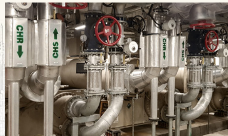
Hệ thống máy làm lạnh trung tâm Chiller system
