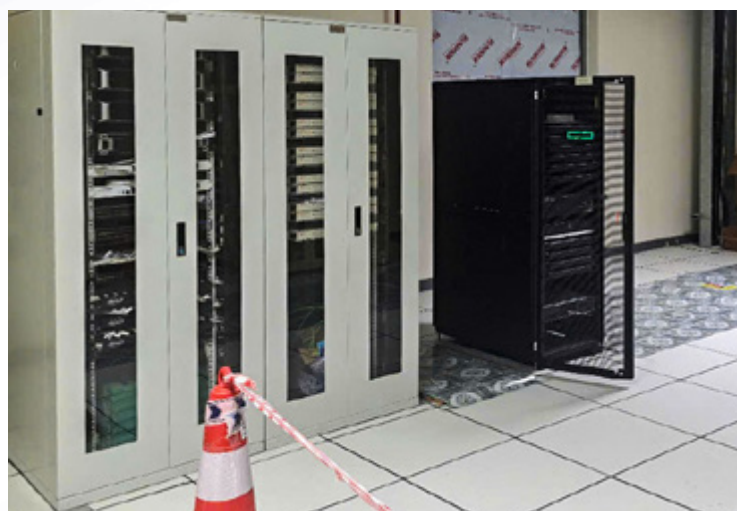
Cụm tủ mạng và tủ máy chủ trong giai đoạn hoàn thiện. Network cabinets and server rack installation during fit-out.
