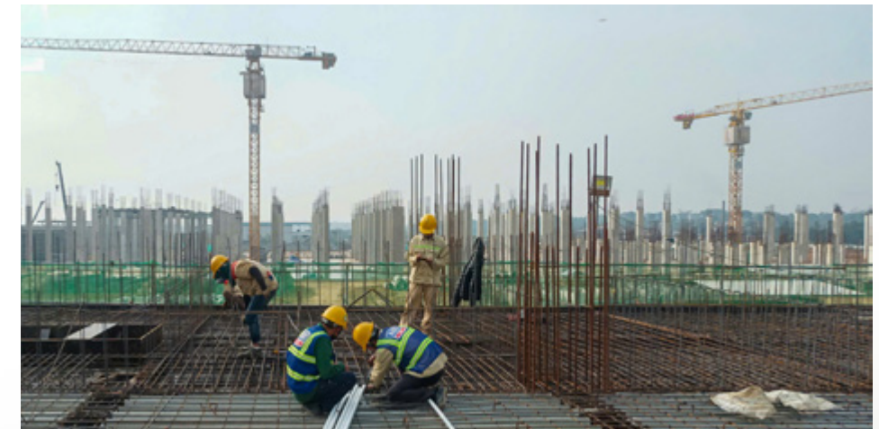
Phối hợp lắp đặt hệ thống ống âm sàn trước khi đổ bê tông. Coordinating the installation of electrical conduits within the slab prior to concrete pouring
