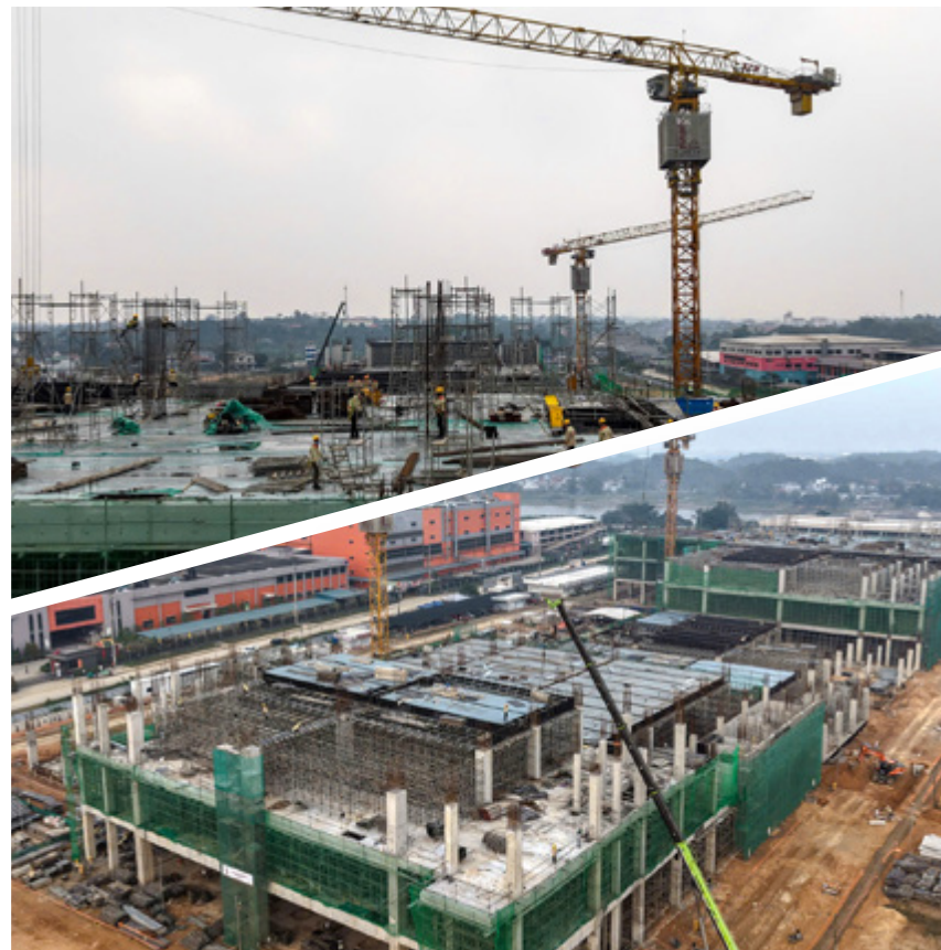
Nhiều mũi thi công được triển khai phối hợp giữa các nhà thầu Coordinated multi-front construction progress at the project site
