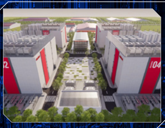
Trung tâm Dữ liệu Viettel An Khánh An Khanh Viettel data center
